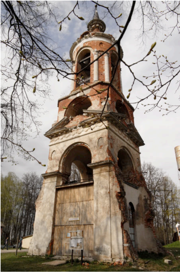
Колокольня церкви Покрова. Вид с юго-запада
