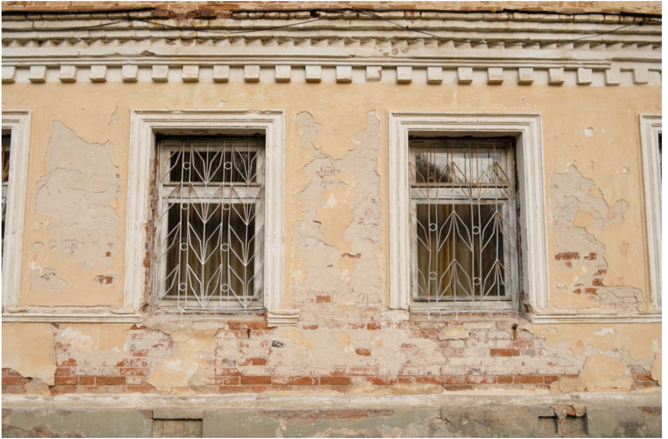
Фото 25. Фрагмент северо-западного фасада
