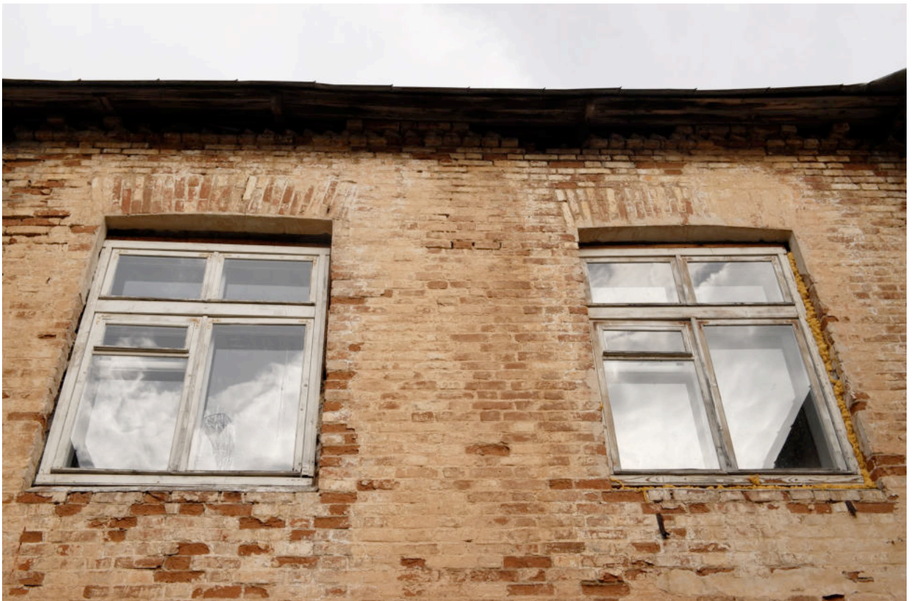
Фото 26. Фрагмент северо-западного фасада
