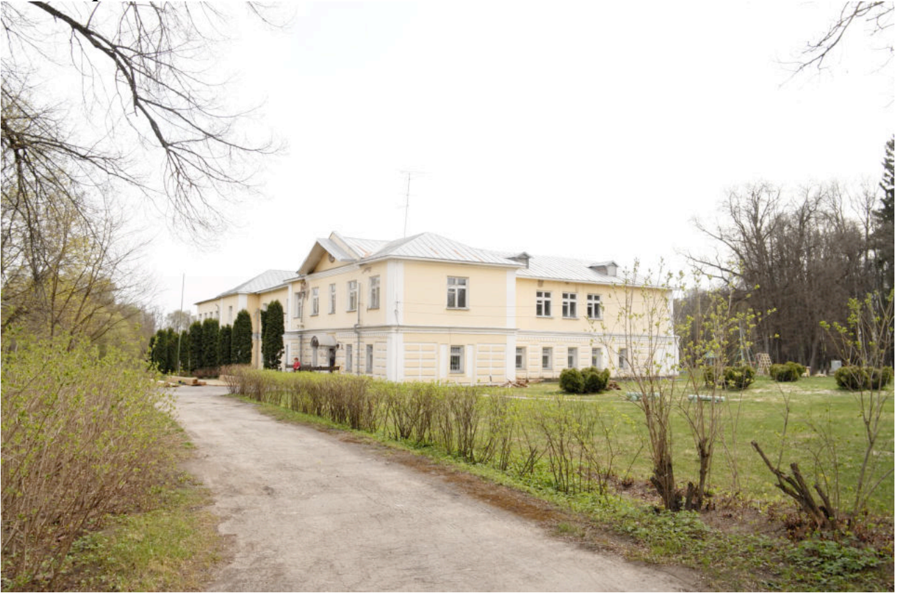
Фото 15. Вид с северо-востока
