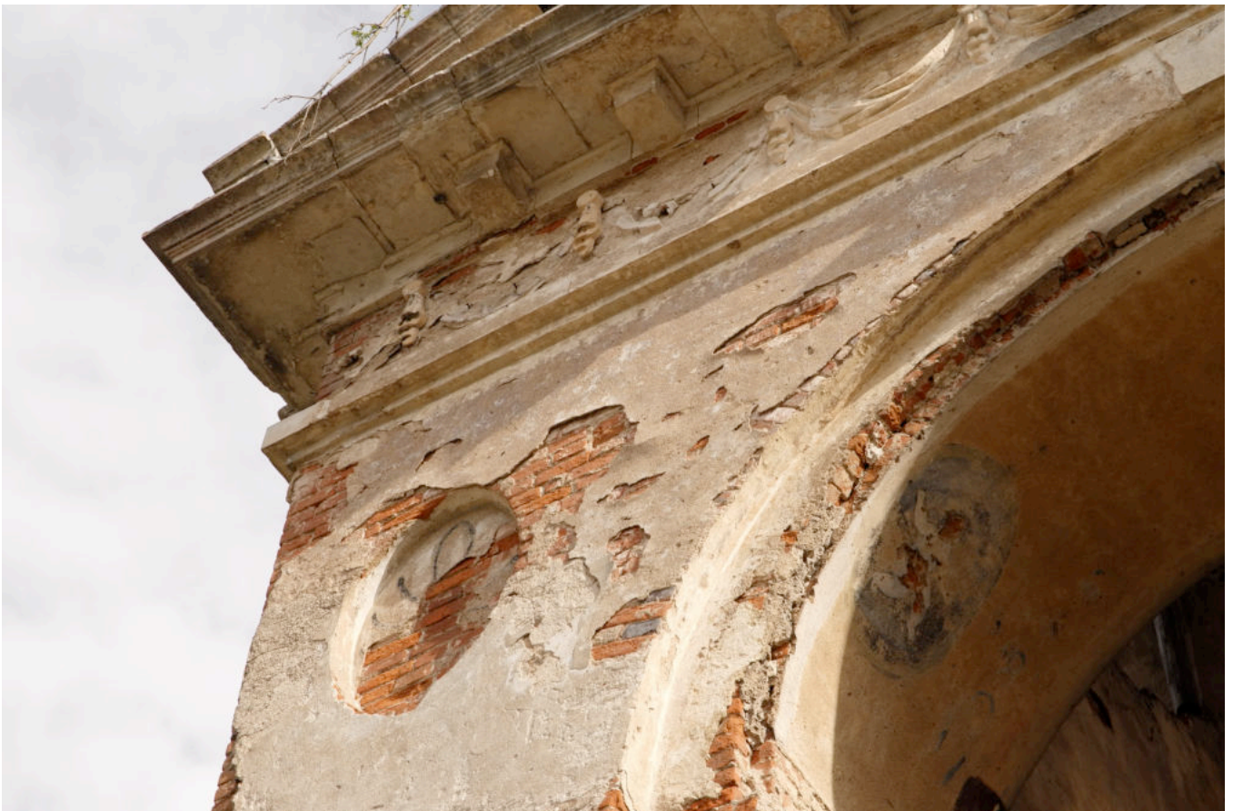
Фото 11. Фрагмент северной стены колокольни
