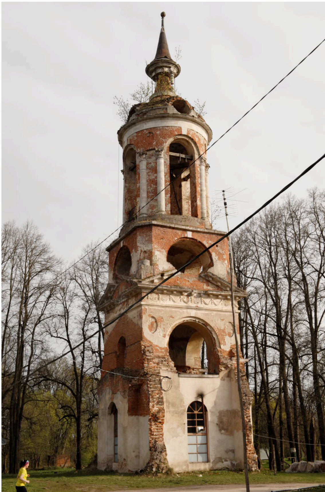
Фото 2. Вид с северо-востока
