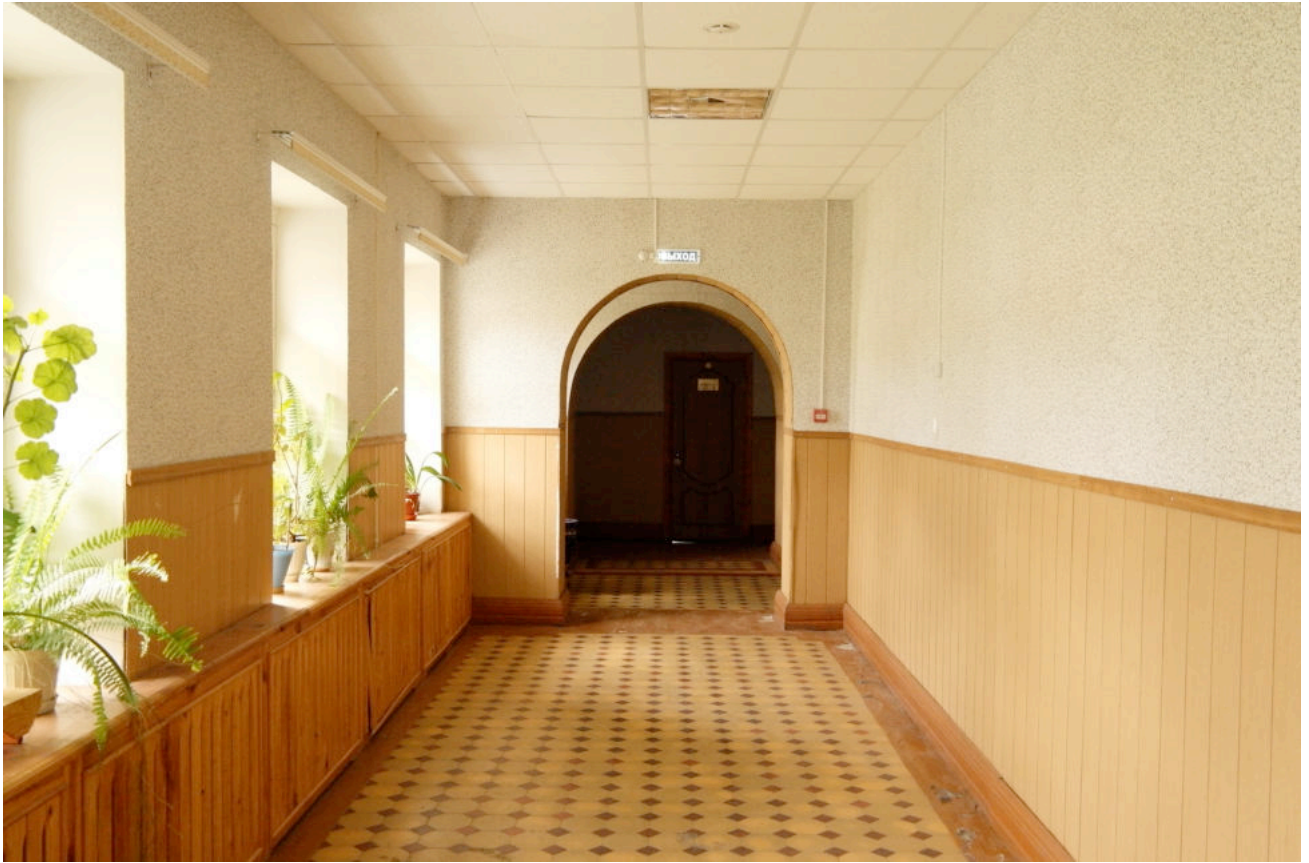
Фото 27. Коридор на 1 этаже здания
