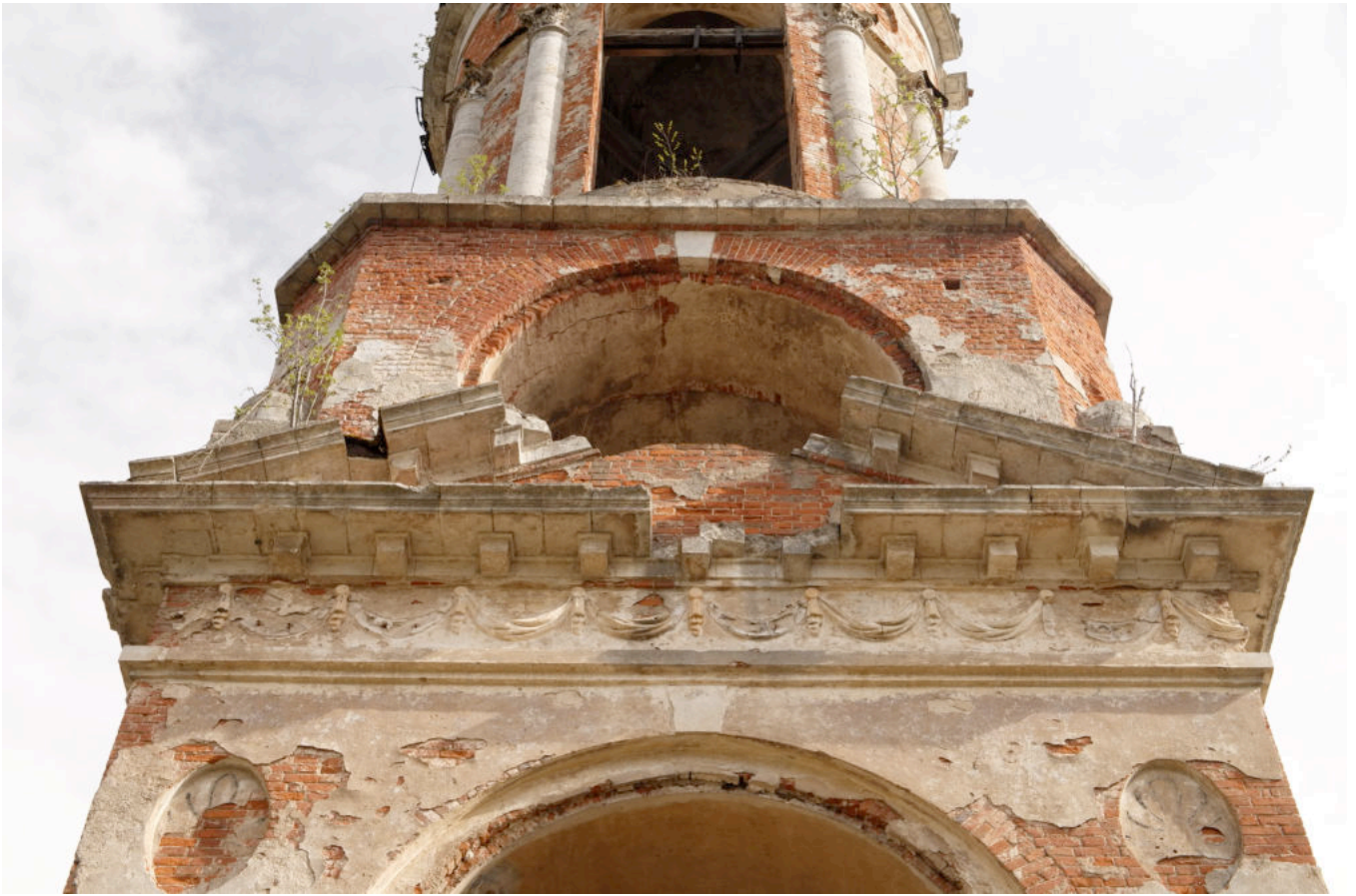
Фото 10. Фрагмент северного фасада колокольни
