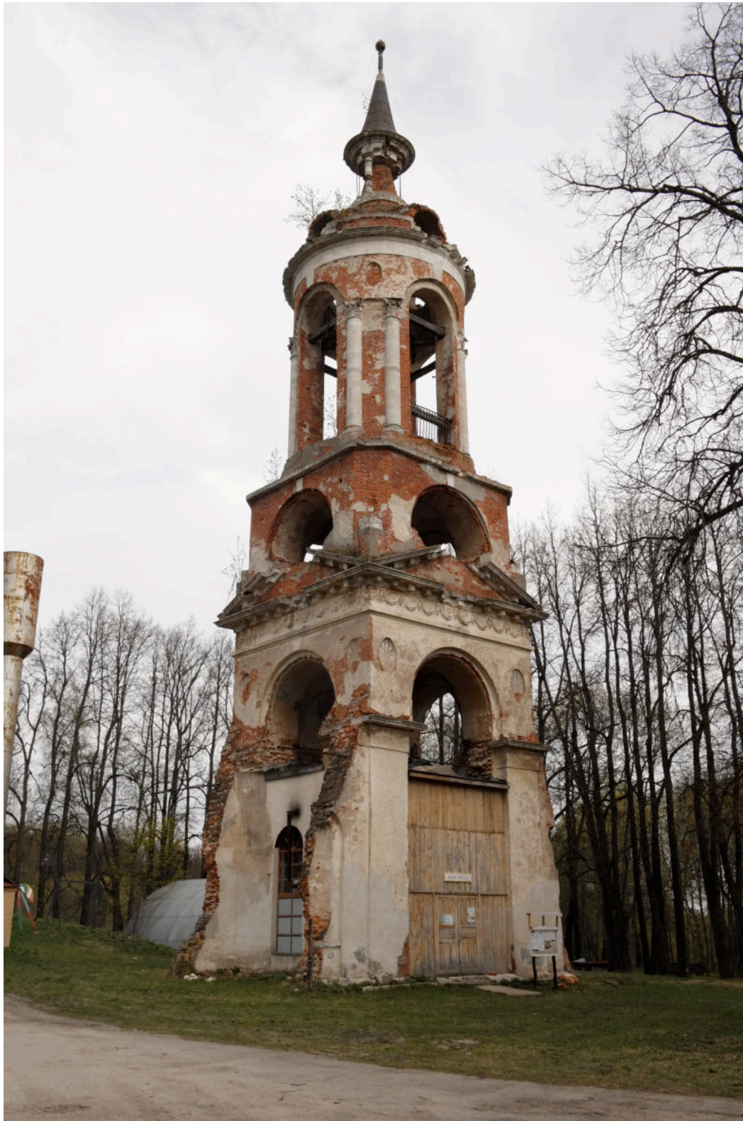
Фото 1. Вид с северо-запада
