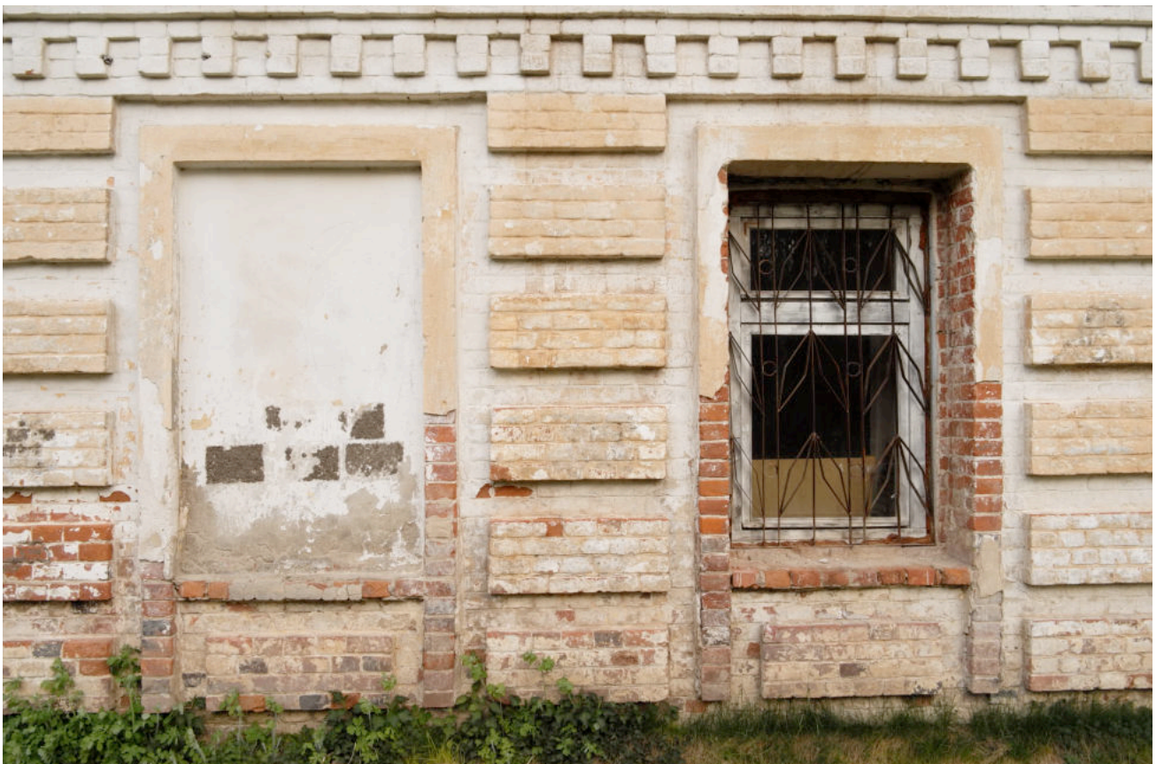
Фото 24. Фрагмент северо-западного фасада
